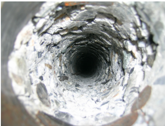
Kernbohrungen mit aufgerauhter Oberfläche
