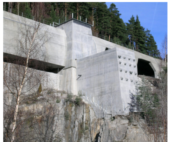
Blick auf das neue Widerlager (ehemalige Verschubbahn)
