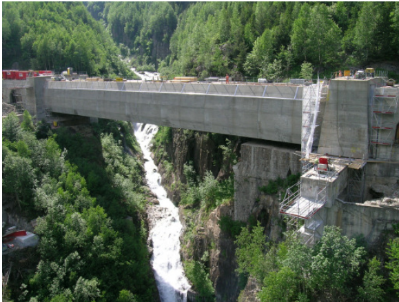
Rorbachbrücke, Blick Richtung Rorbachschlucht
