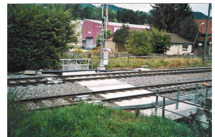
Versetzte Brückenplatten, Gleisroste eingebaut
