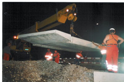
Einbau vorgefertigte Brückenplatte während Nachtintervall
