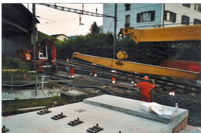
An Ort vorgefertigte Brückenplatte mit direkter Schienenbefestigung
